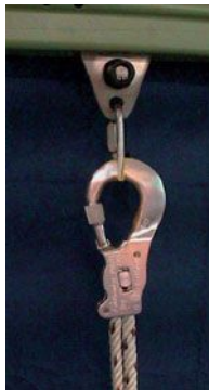
Abbildung 11-3: Anschlagseinrichtung mit horizontaler Führungsschiene und beweglichem Anschlagpunkt
